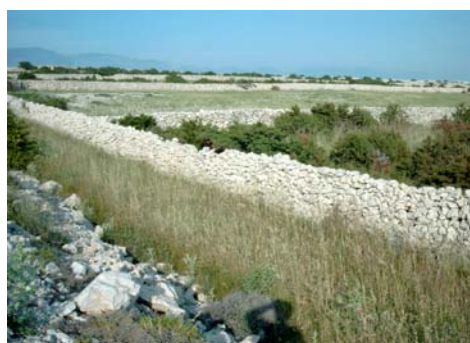
Legesteinmauern zur Weidenbegrenzung und Reduzierung der Windgeschwindigkeit (Foto: M. SCHWEIGER)
